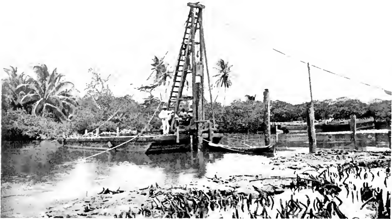
DRIVING PILES FOR THE WHARF AT NOMBRE DE DIOS.
